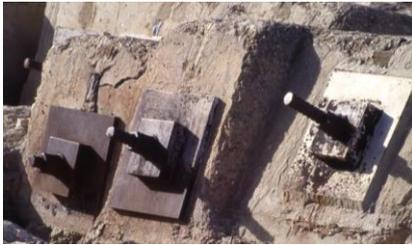
La nature s'est montrée également agressive notamment par les crues du Gardon qui ont creusé des cavernes sous-marines dans les massifs rocheux supportant les piliers. Les derniers travaux importants pour traiter ce problème et consolider le pont, ont été réalisés en 2002. Des tiges filetées de 20 mètres de long ont été enfoncées dans ces massifs rocheux. De plus ces travaux ont permis de constater que sous le Gardon se trouve une faille tectonique secondaire de la faille dite de Nîmes.
